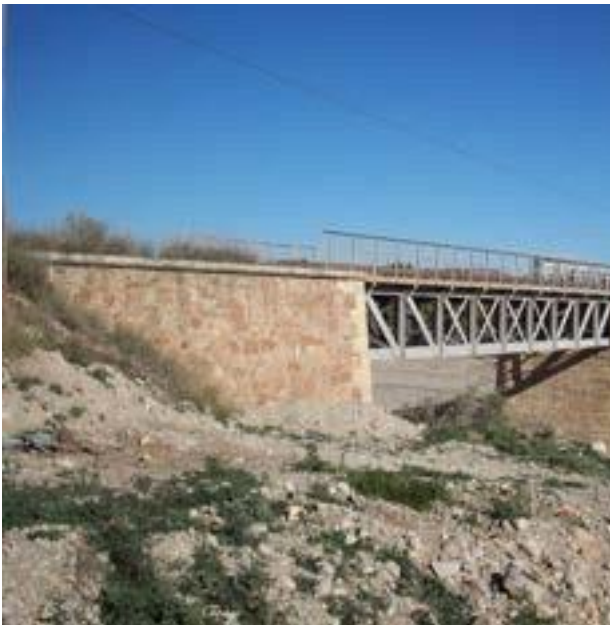
Puente de Almanzora sobre la rambla de Albox
