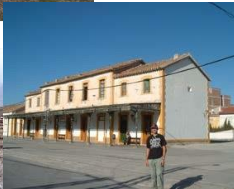
Recinto de la estación de Baza
