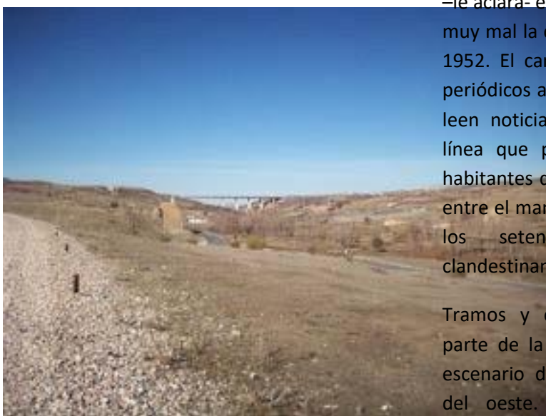
Arroyo de Gor con los estribos del puente desmantelado a cada lado y el puente de la autovía A92 al fondo.
