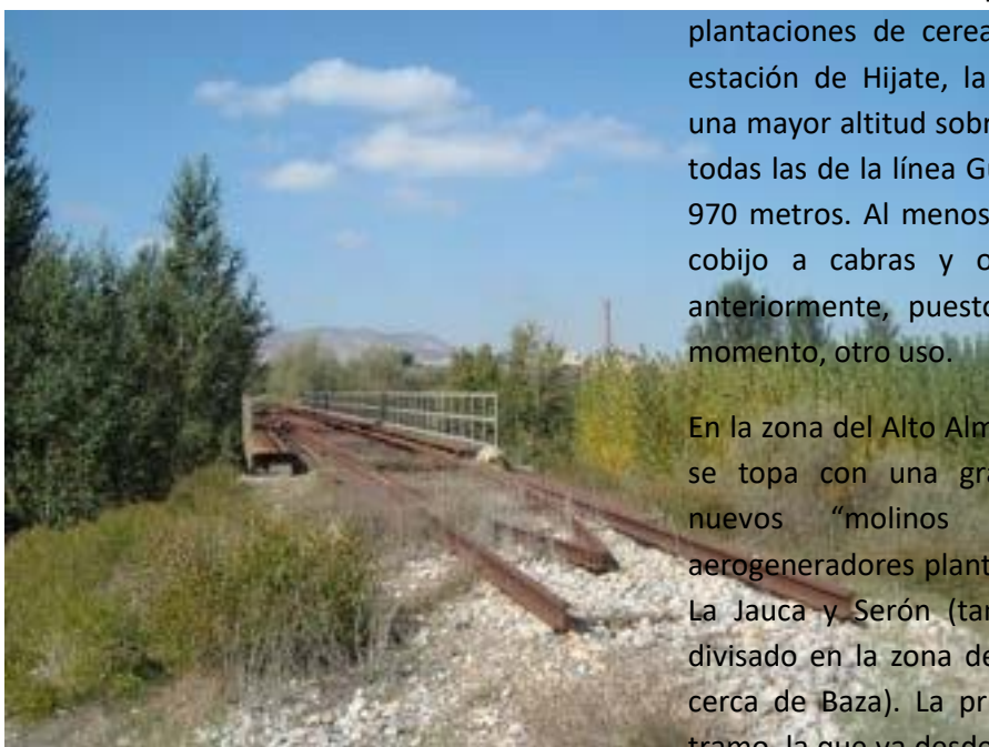
Puente sobre el río próximo a la estación de Caniles. La chimenea de la azucarera Nuestra Señora de las Mercedes se aprecia al fondo.
