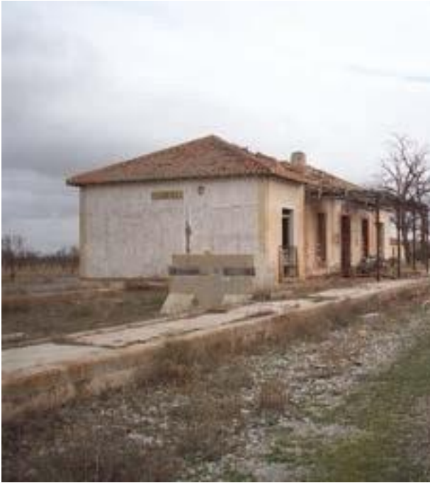
Estación de Zújar - Freila
