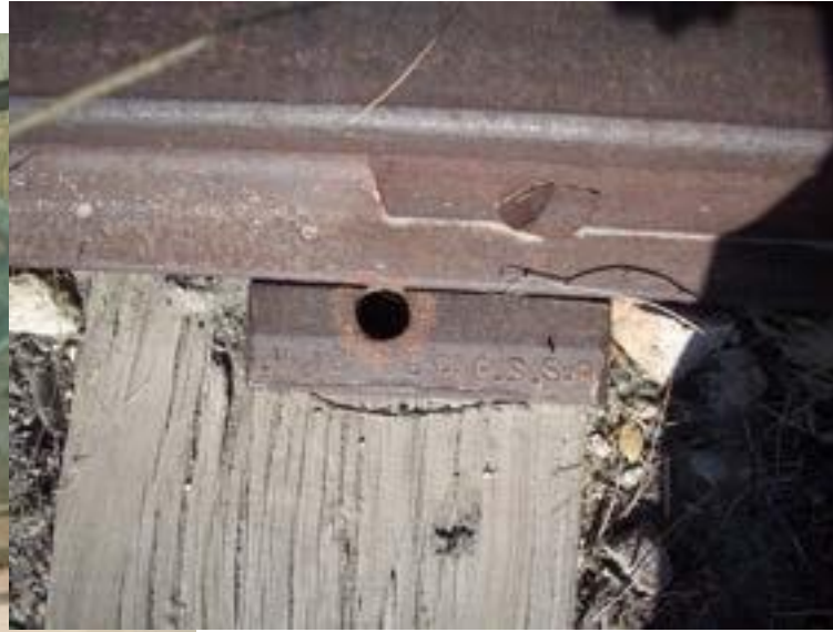
Placa de sujeción de tirafondos, estación de Tíjola.
